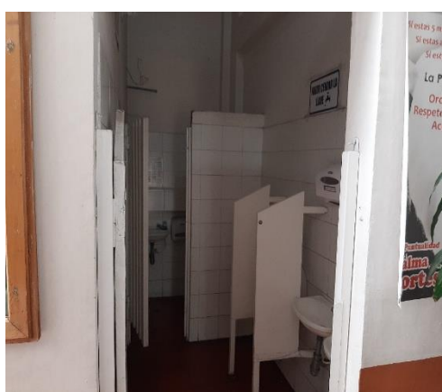
Ein Teil der WCS für Männer und Damen Toiletten
