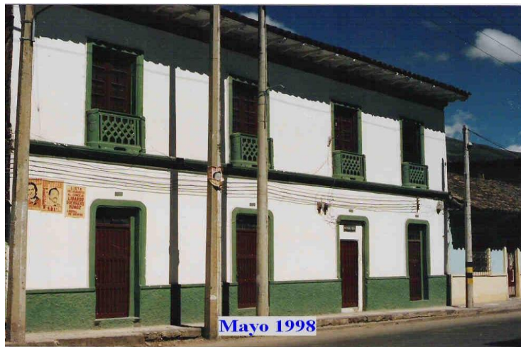
Fassade im Jahr 1998
