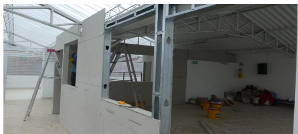
Die Bauarbeiten auf der Terrasse 07.01.2019
