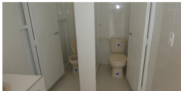
Vier Toiletten mit Lavabos wurden gebaut. 30.01.2019
