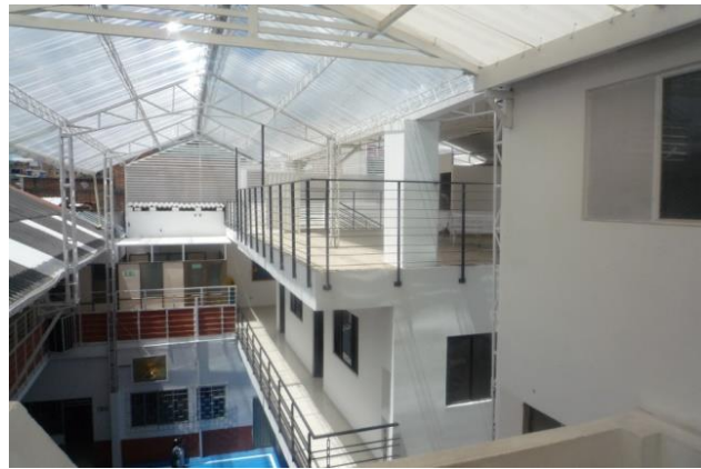
Das neue Dach 10.05.2018
