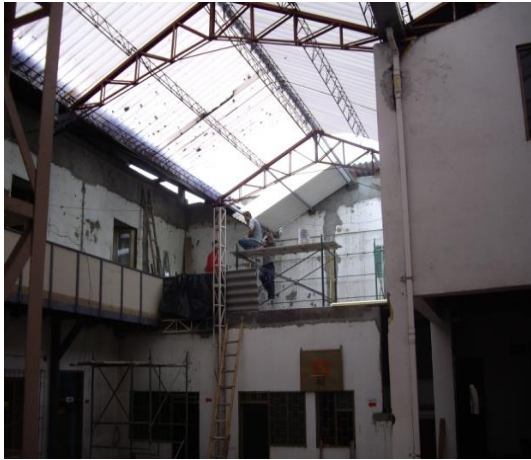
Das alte Dach des Hofes 17.11.2017
