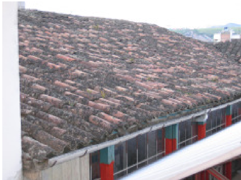
Altes Dach von NUEVA CULTURA, Januar 2007
